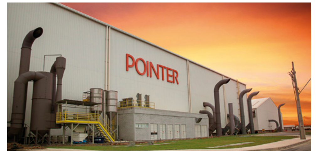
Fábrica Pointer, em Marechal Deodoro, AL
