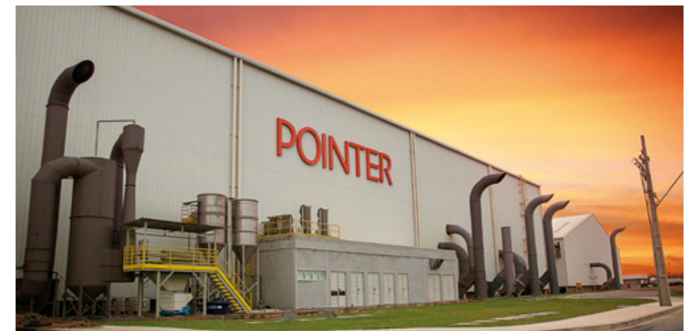
Fábrica Pointer, em Marechal Deodoro, AL
